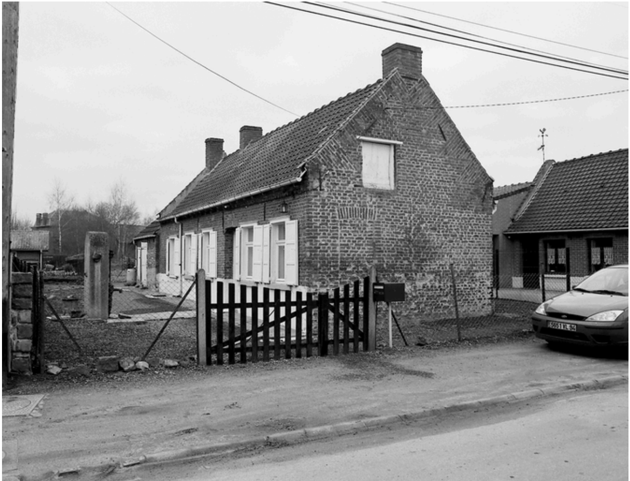
Maisons élémentaire, rue de la Lombarderie.
