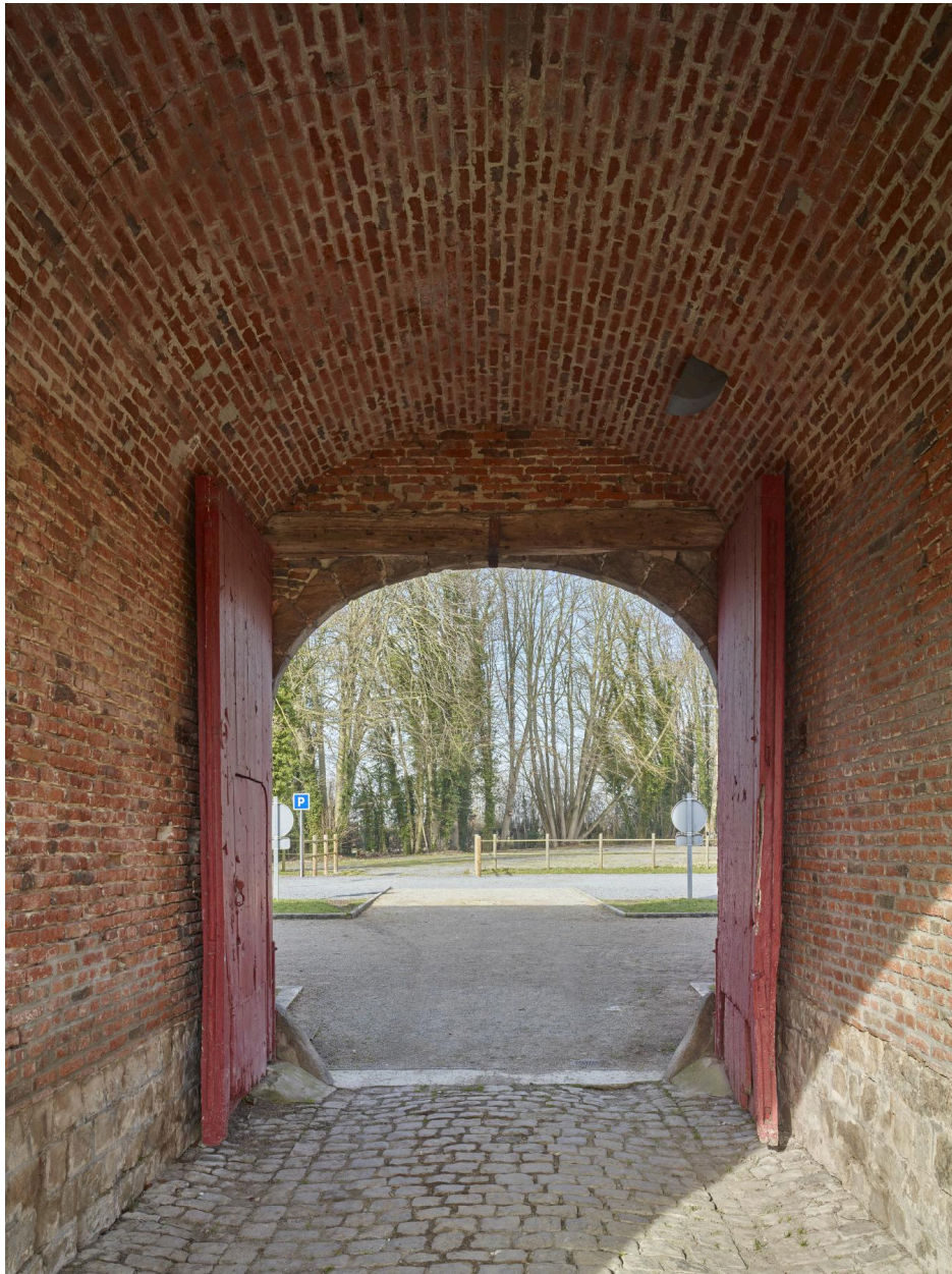
Passage charretier sous la tour porche. Vue prise vers la rue.
