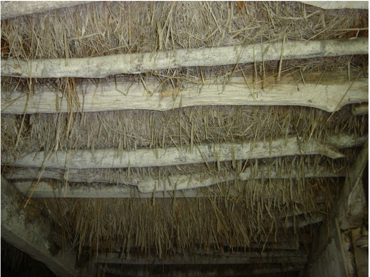
Détail de la composition du plafond des étables.
