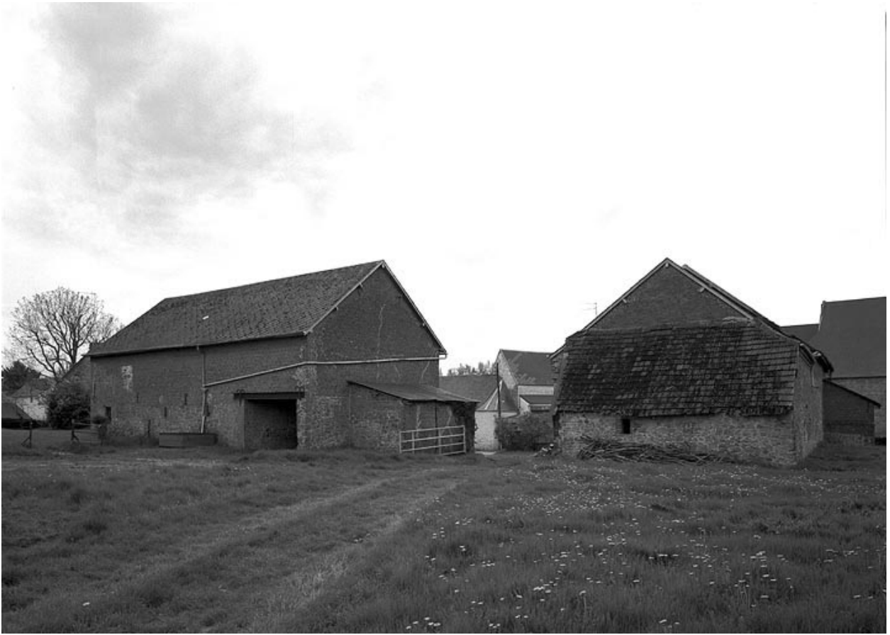
Vue de l'élévation postérieure des bâtiments d'exploitation.
