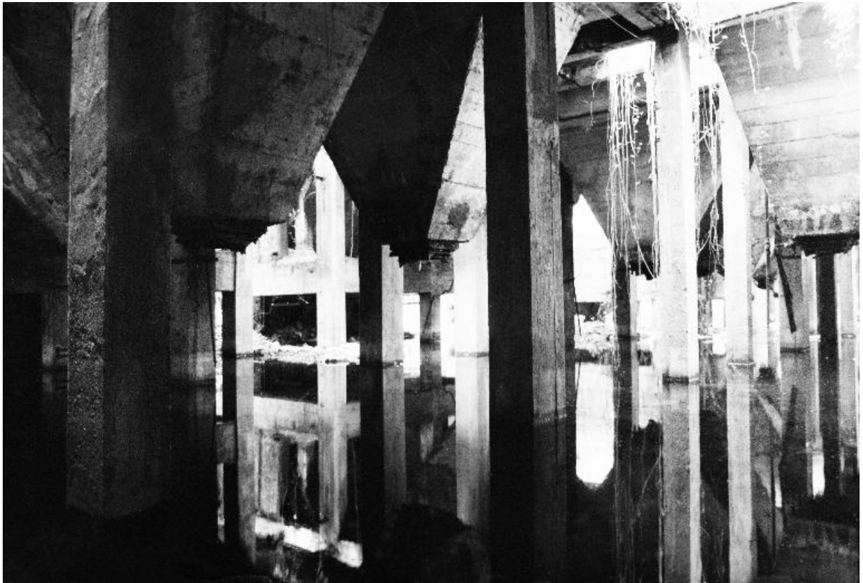
Atelier, salle des goulottes, détail.
