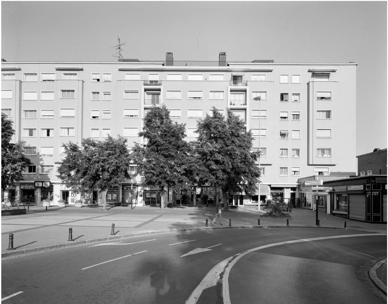
Vue partielle de l'élévation sur la place des Nations, vers l'avenue Jean-Mabuse.
