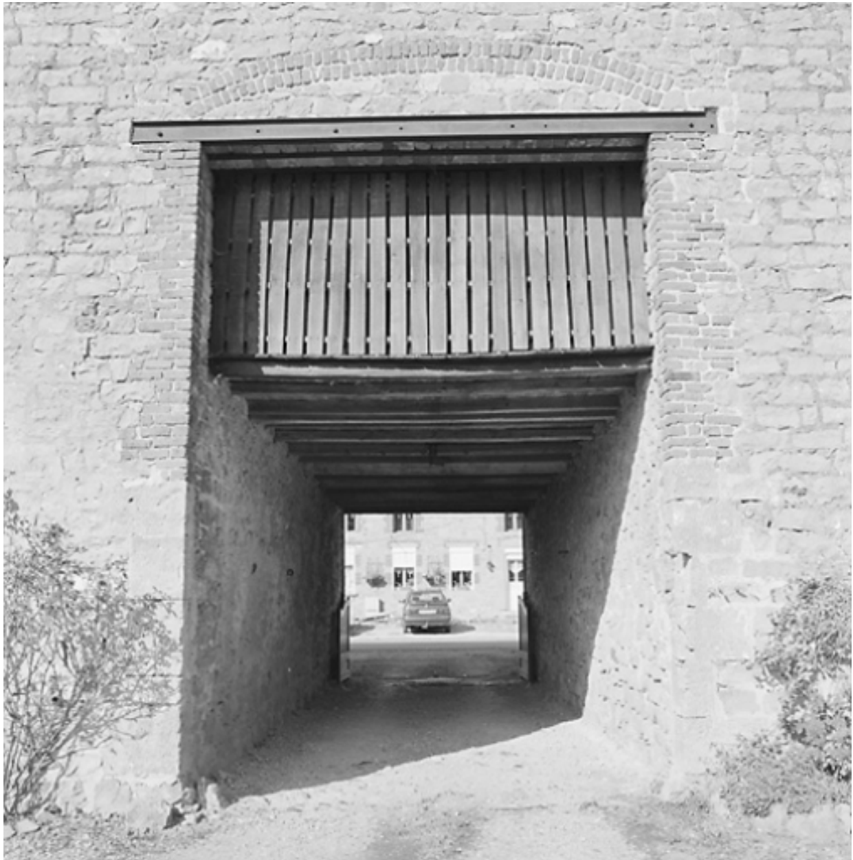
Vue du passage chartier, depuis la cour.
