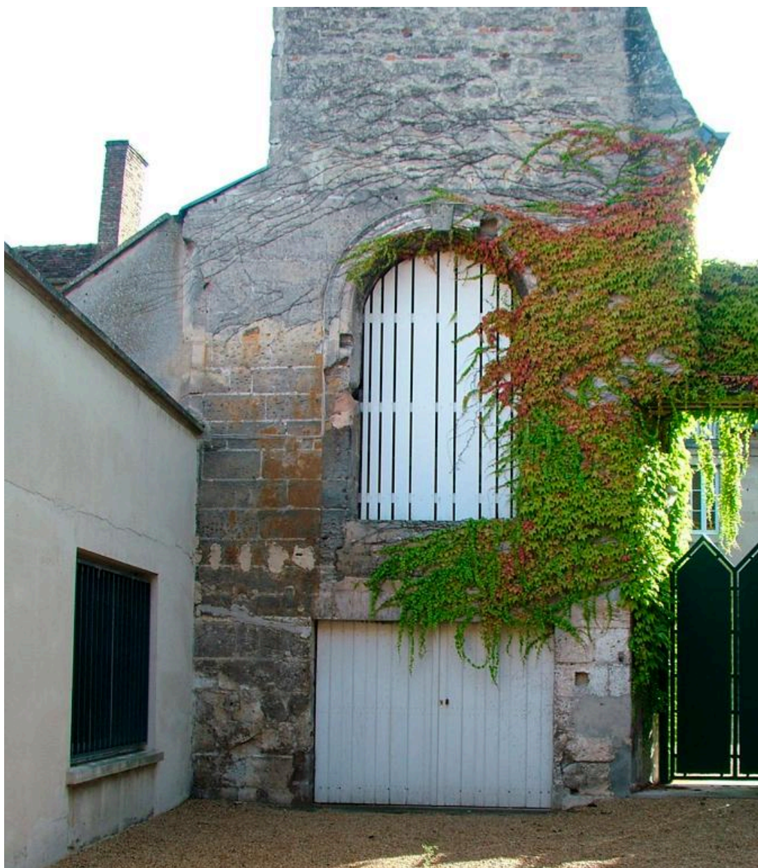
Vestiges de l'élévation de l'ancienne église prieurale.
