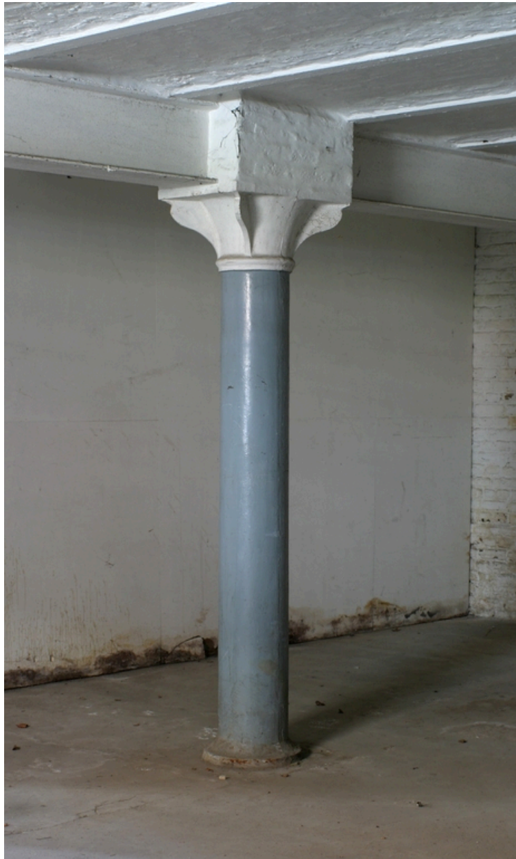
Ateliers antérieurs à 1900 (ensemble ouest) : une colonne du sous-sol.
