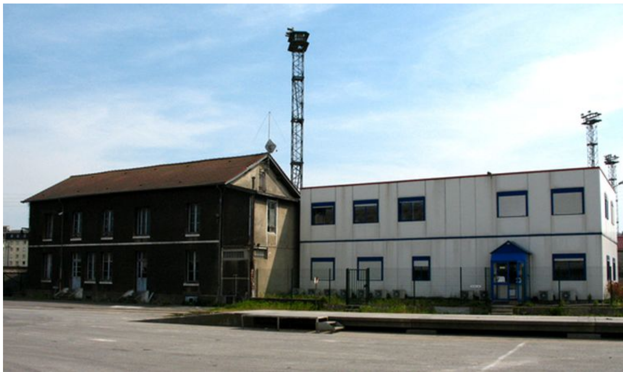
Les bureaux de l'usine.
