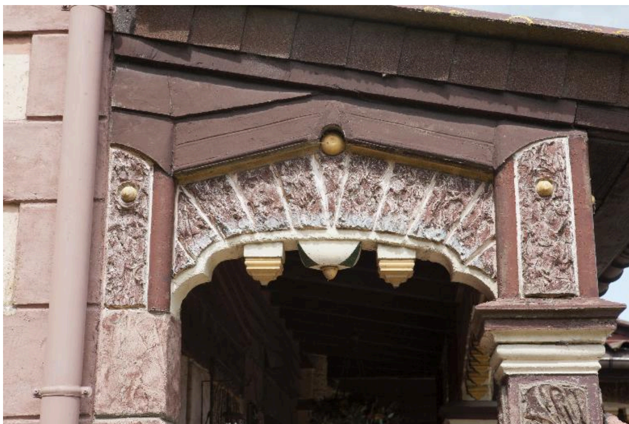
Terrasse, détail des arcades.
