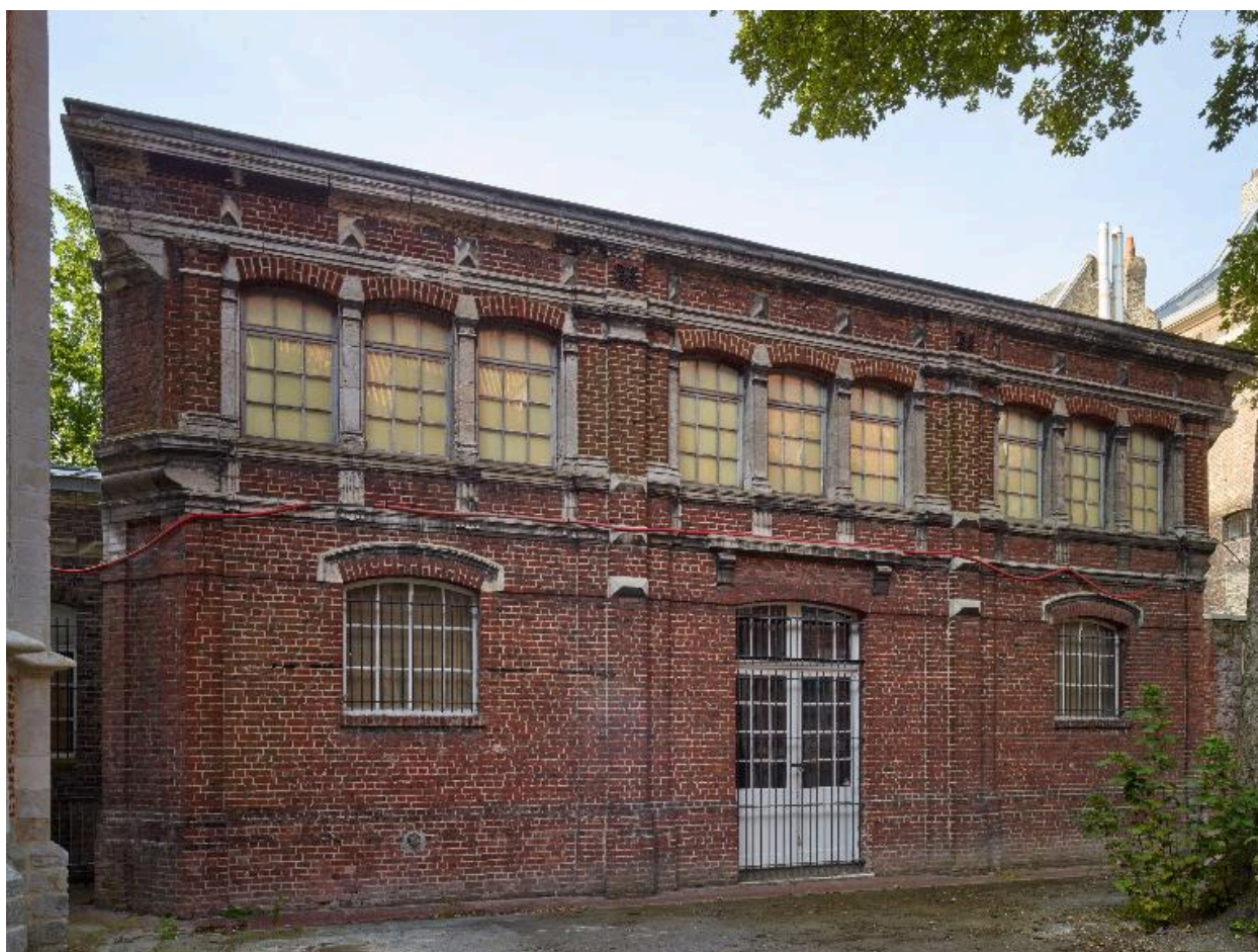
Vue général côté sud.
