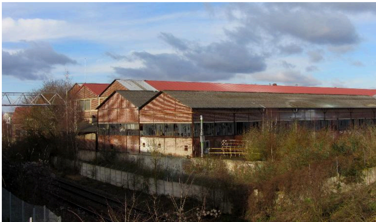
Vue d'ensemble des ateliers depuis la ligne de chemin de fer.
