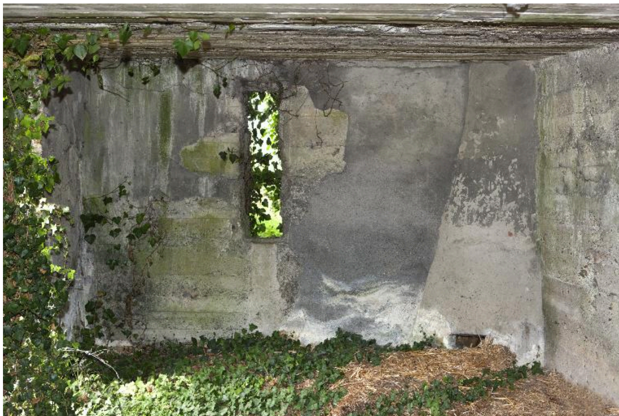
Casemate a). A droite une cheminée
