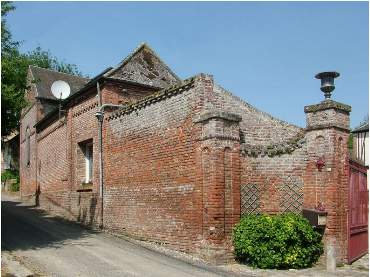
Bâtiments sur la rue Mulot.
