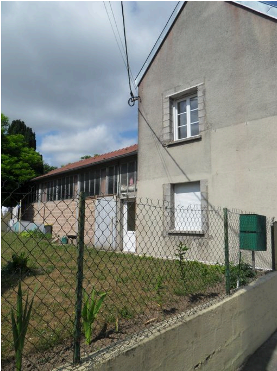
Ancienne scierie, 18 rue de Vignacourt.
