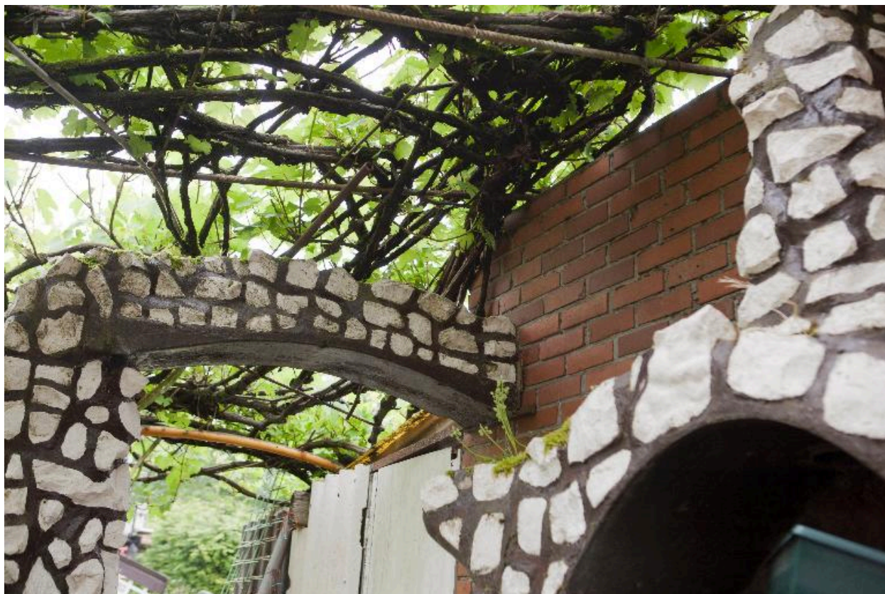
Vue de la cour, détail.
