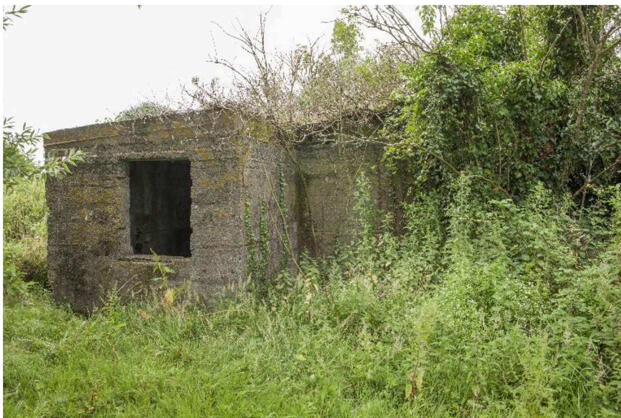
Casemate a), élévation ouest
