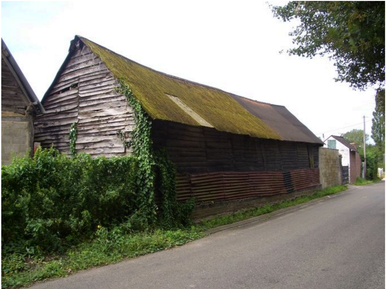
Vue de la grange longeant la rue.
