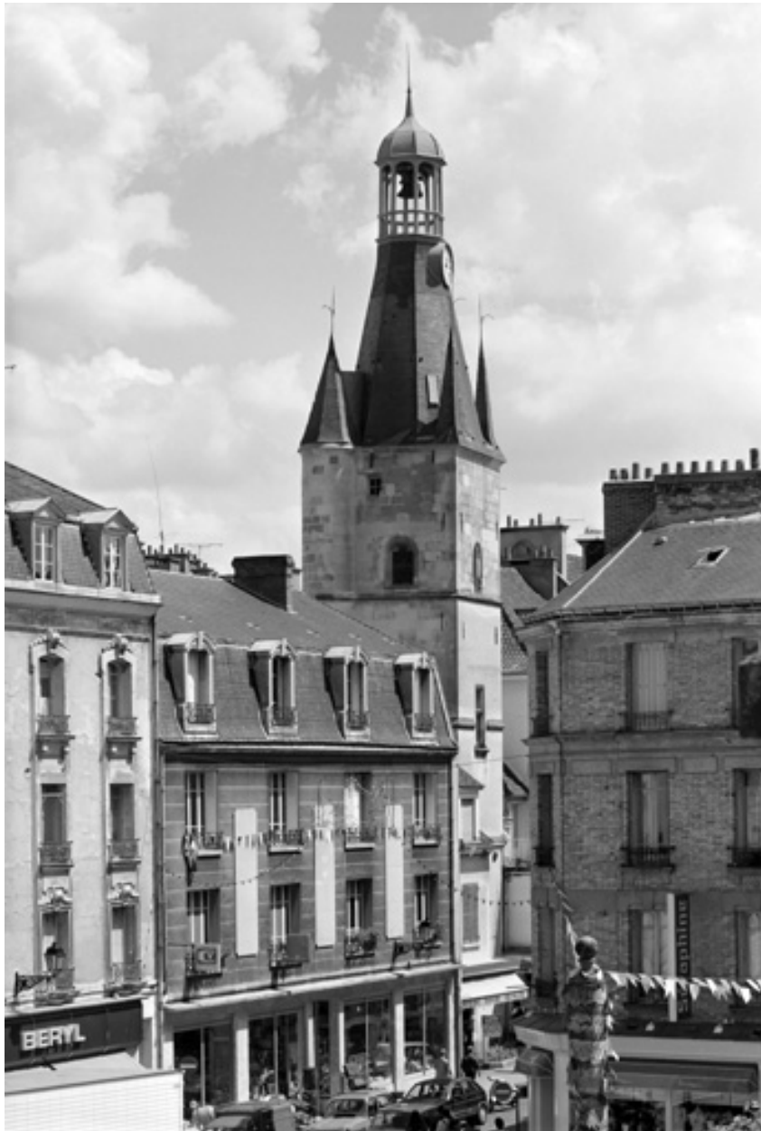
Vue d'ensemble depuis le toit du marché couvert.
