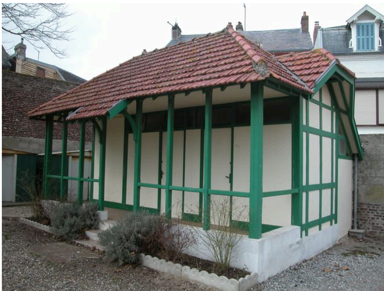
Les vestiaires, vue de trois-quarts.
