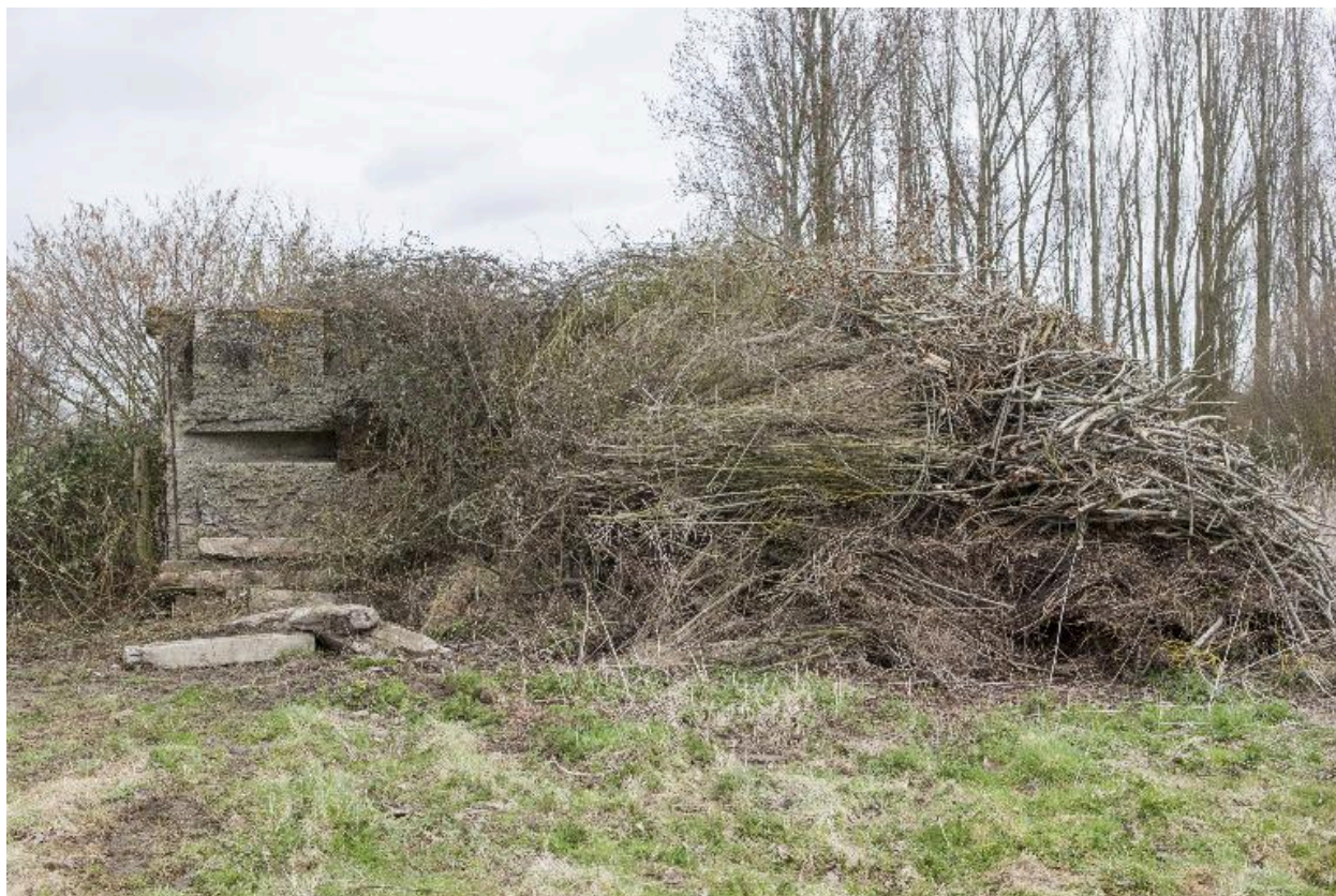
Vue latérale, vers le nord
