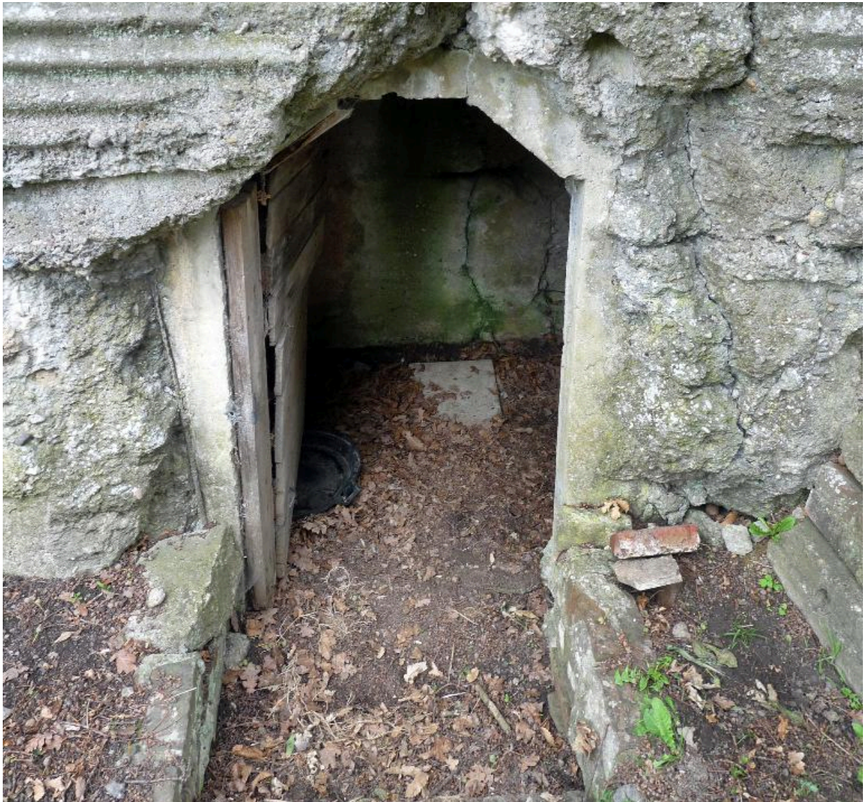
Entrée de l'élévation sud.
