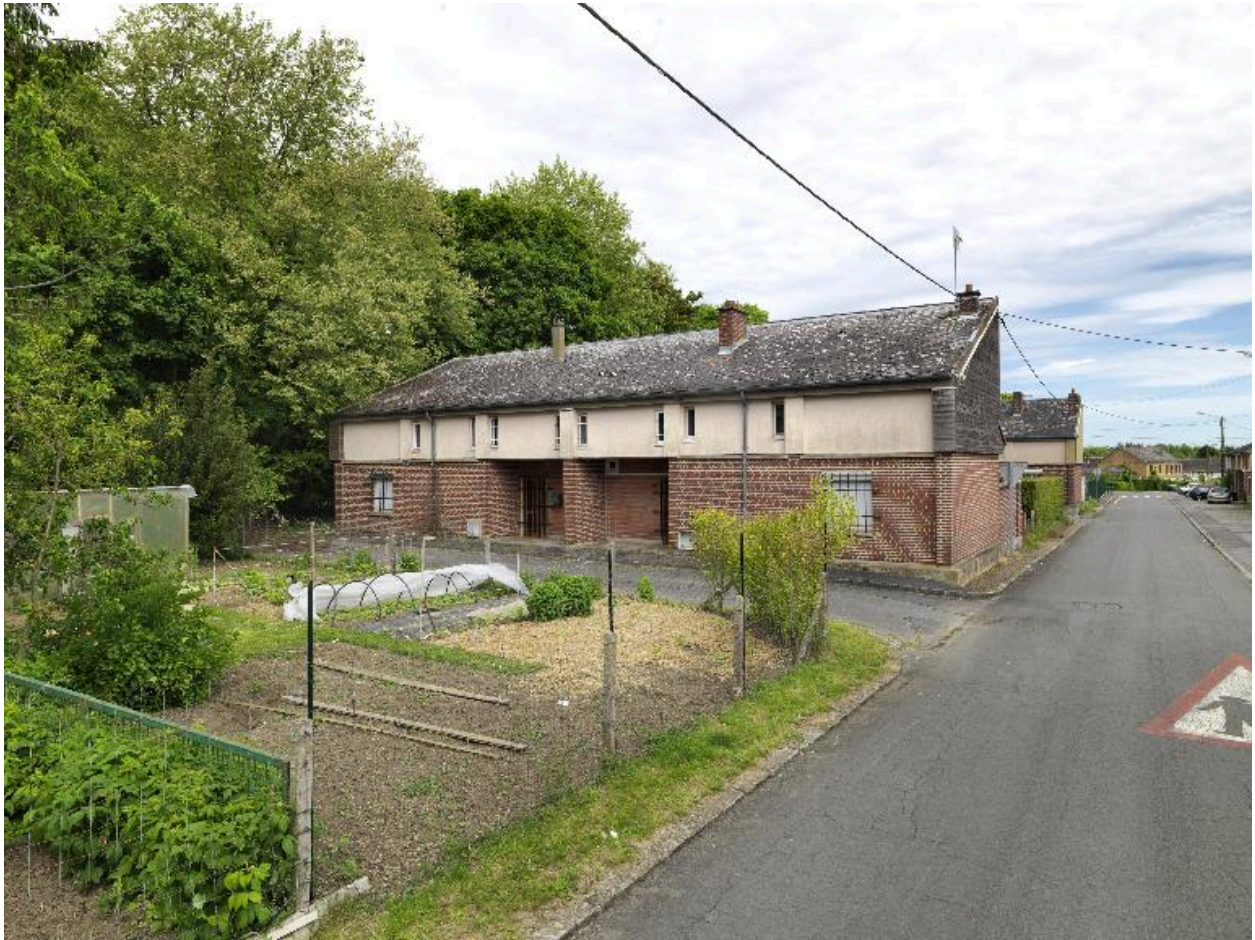
Maison à deux unités d'habitation, façade postérieure (rue de la Famille-Vernet).
