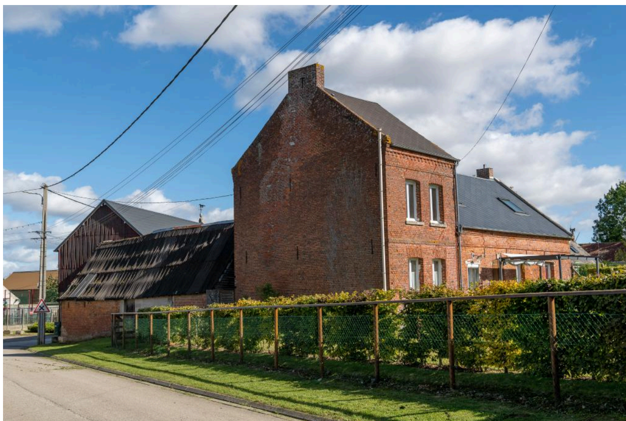
Ancienne ferme avec logis en brique, n°11 Grande Rue.
