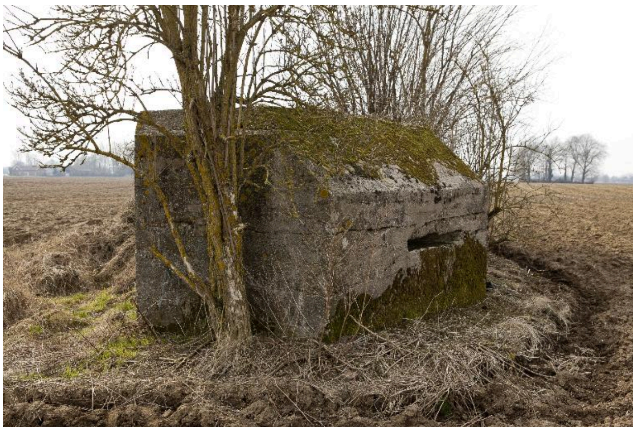
Vue latérale, vers le sud-ouest
