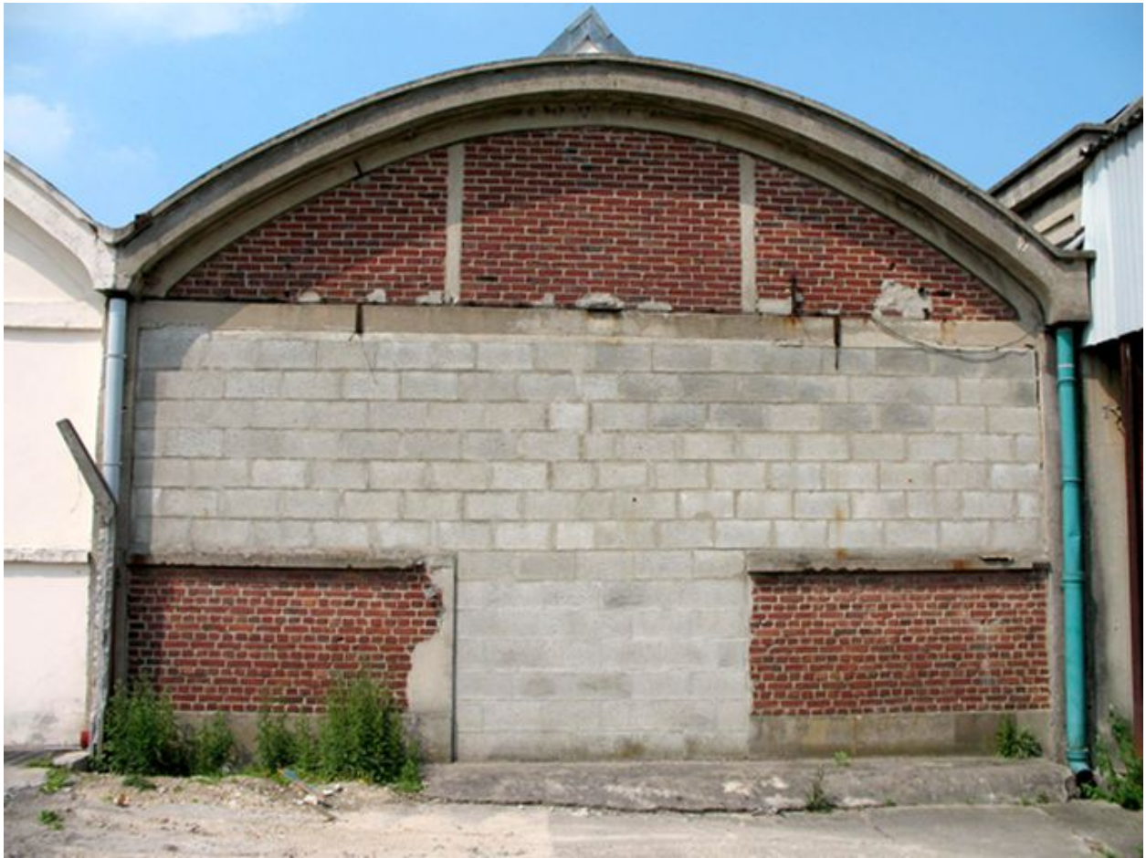
Détail d'une travées des ateliers de fabrication.
