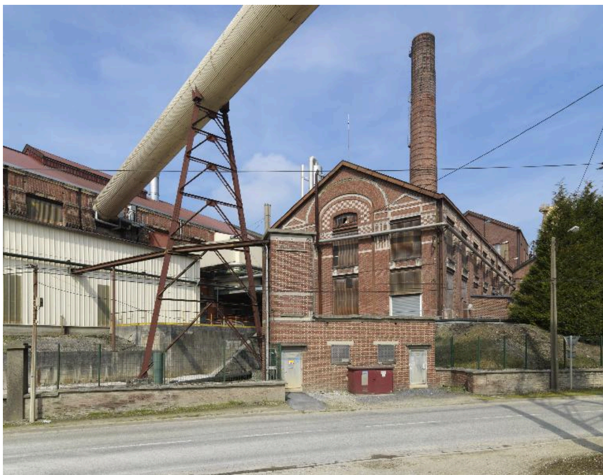
Vue d'ensemble sud-ouest de l'atelier de fabrication principal de la sucrierie.
