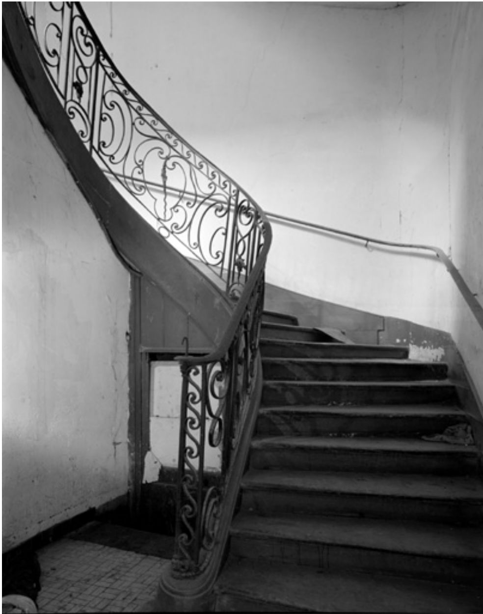
Vue de l'escalier en fer forgé dans la première aile en retour.
