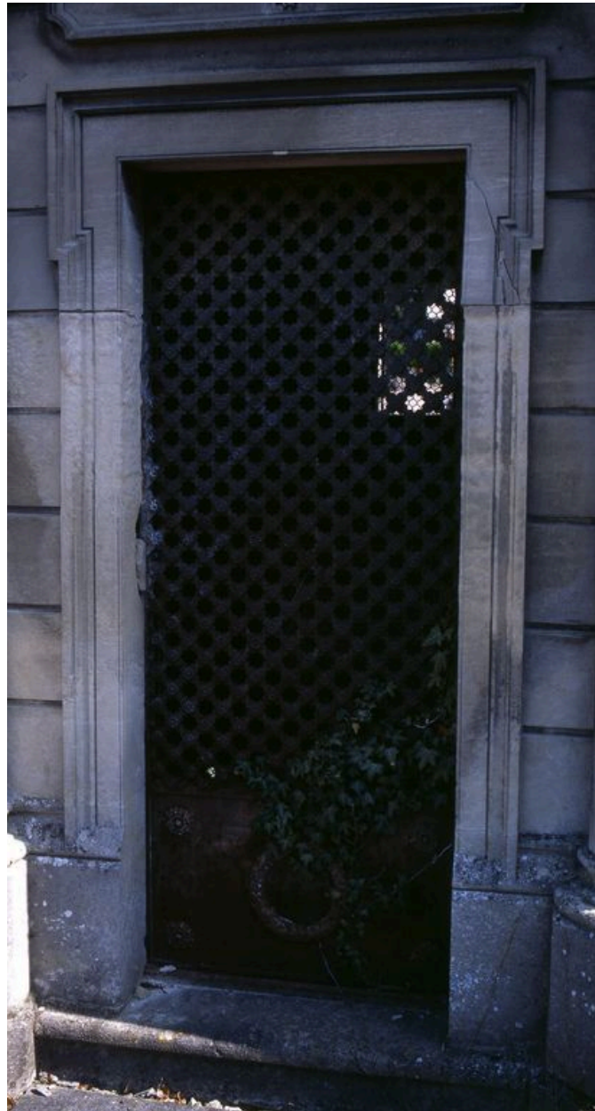
Vue de détail sur la porte en fonte.
