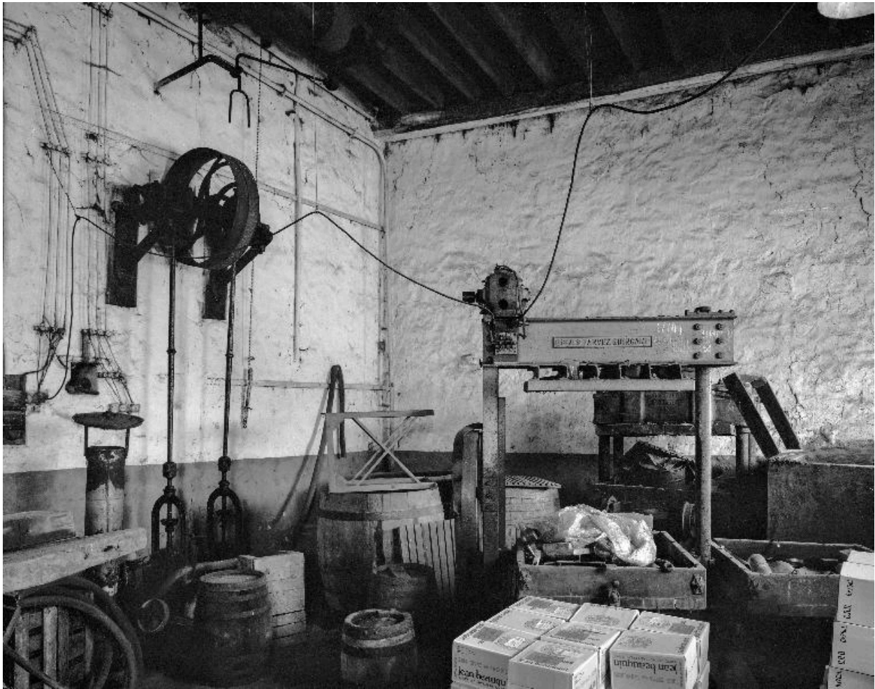
Vue partielle de l'atelier de fabrication.
