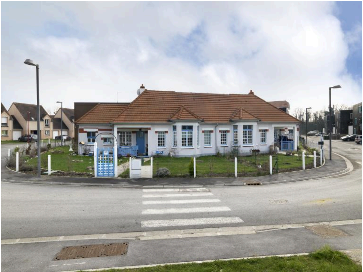
Maison à deux unités d'habitation (modèle A), 17 allée des Acacias et 16 allée des Jardiniers.
