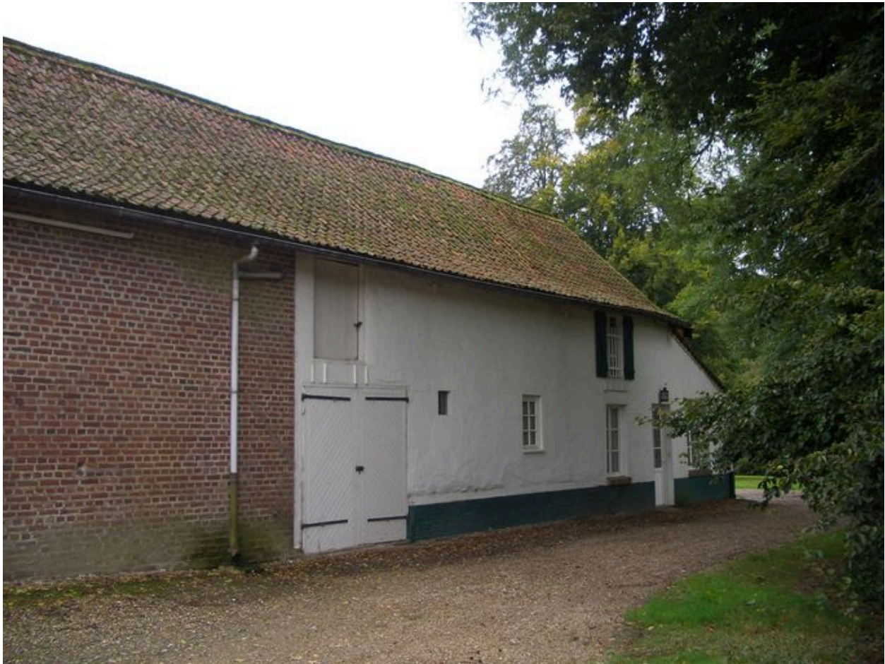
Vue du logis accolé aux bergeries.
