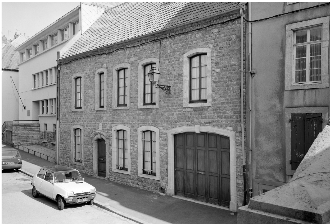
Vue générale sur voie.
