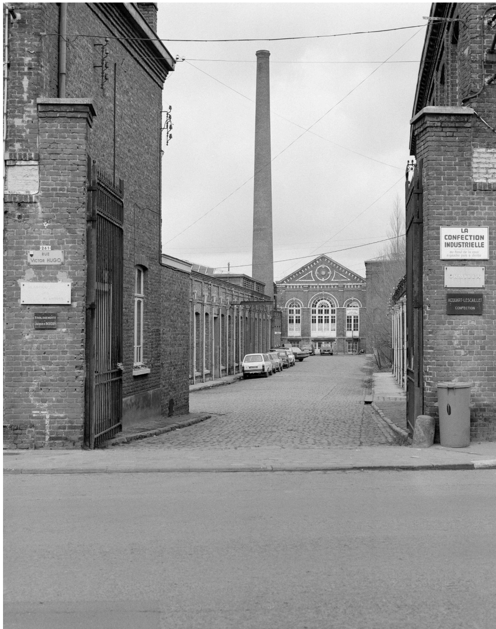
Vue générale depuis la rue. Vue prise vers le nord.
