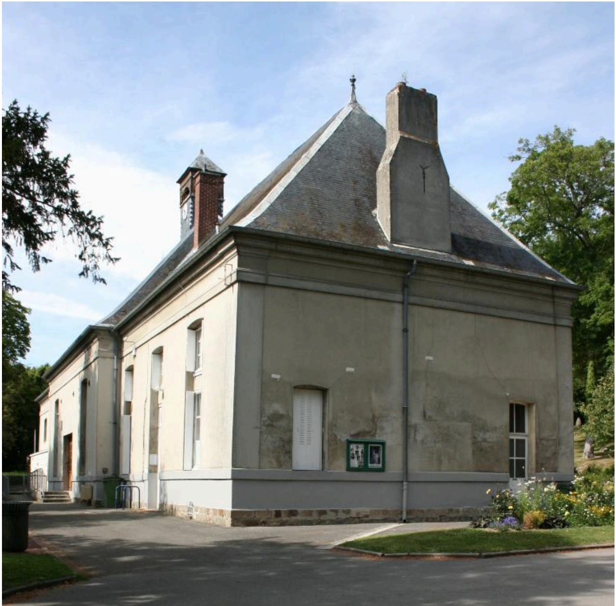
Vue depuis le sud-est.
