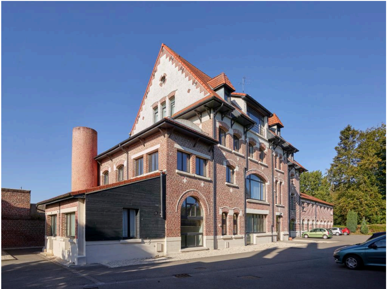
Façade sur cour de l'ancienne brasserie vue depuis l'entrée de la cour.
