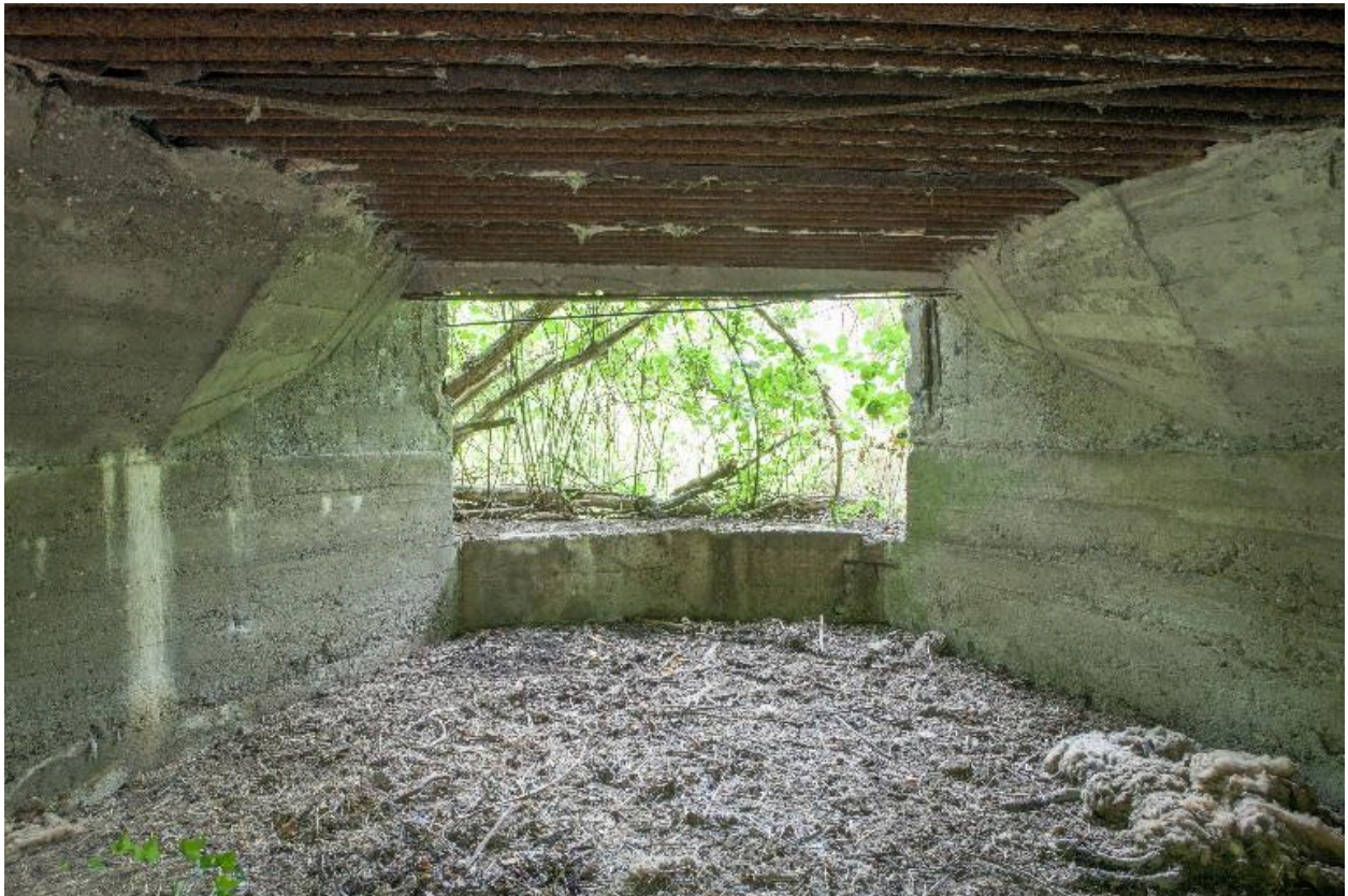
Sortie de la chambre de tir
