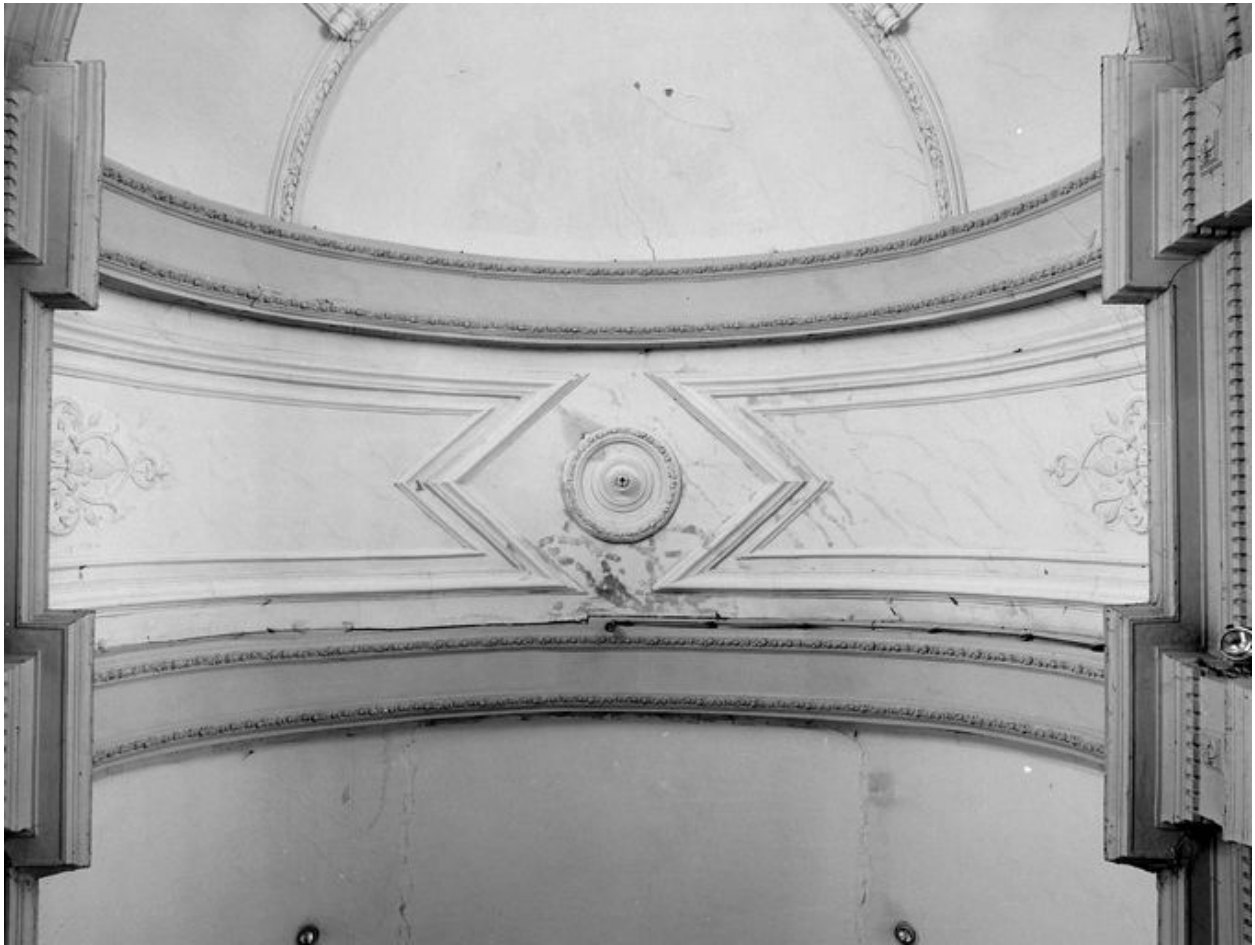
Détail des moulures en stuc, à l'entrée du chœur.
