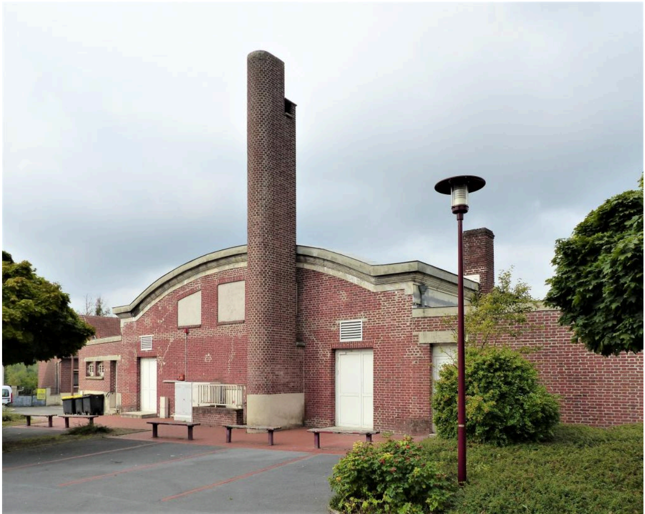
Vue de la façade sud.
