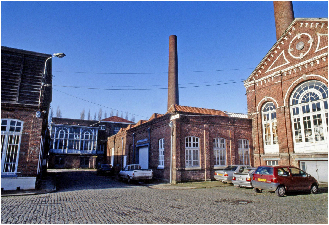
Vue générale vers l'ouest prise depuis la cour.
