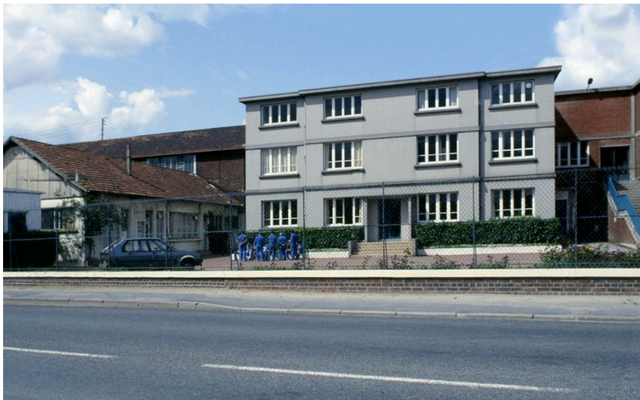
Façade côté rue des bureaux, 1992.
