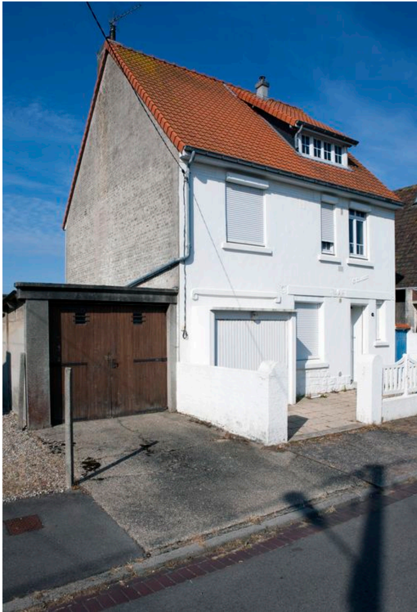
Vue générale de trois quarts avec le garage
