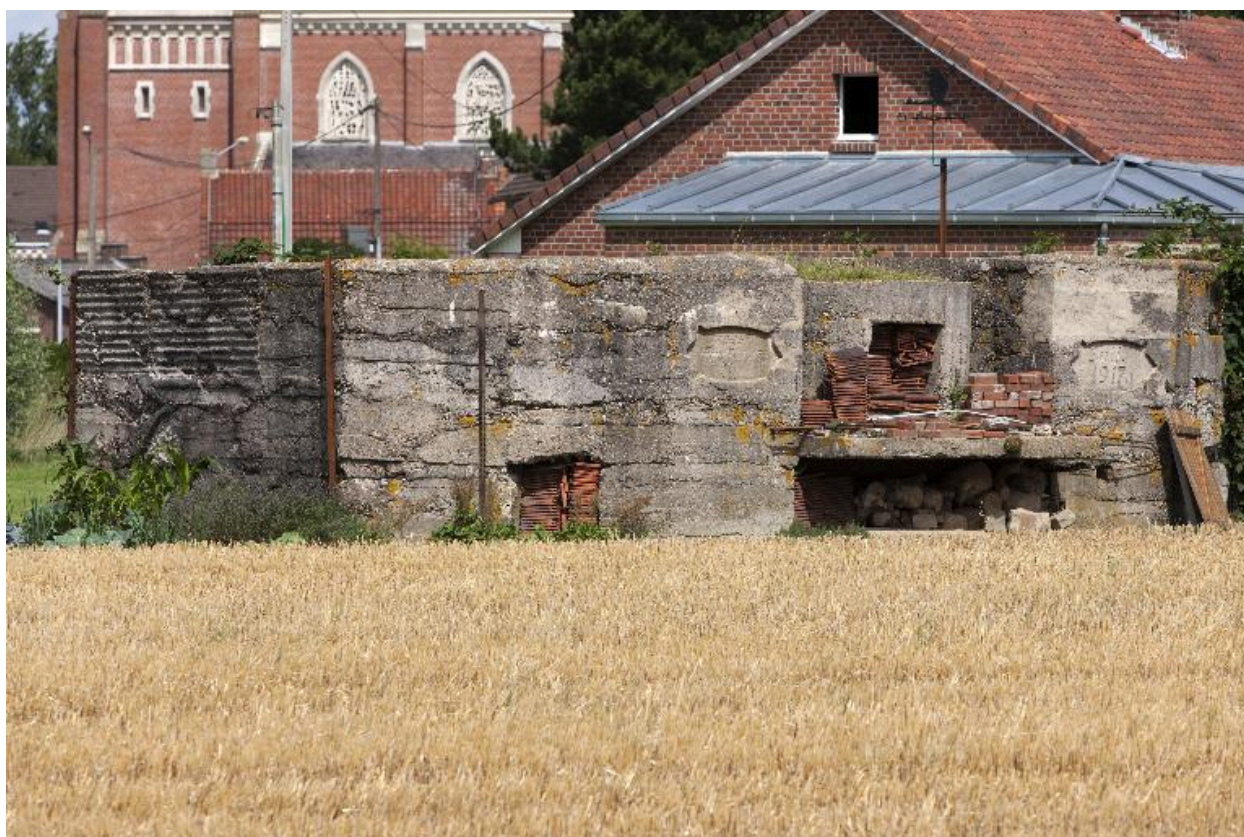
Vue de trois-quart; vers le nord
