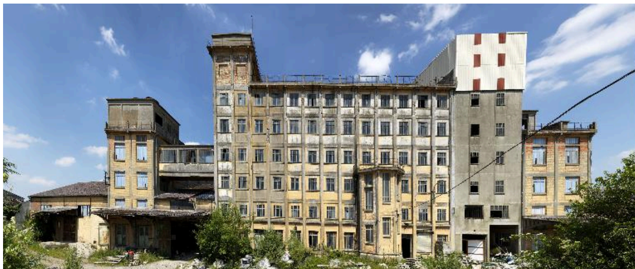
Façade sud de la minoterie.
