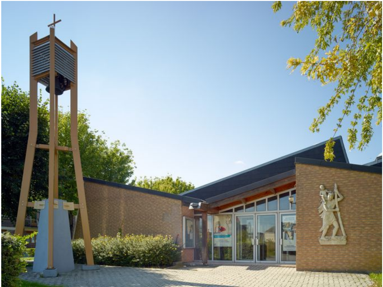
Élévation principale côté est, parvis avec son clocher.
