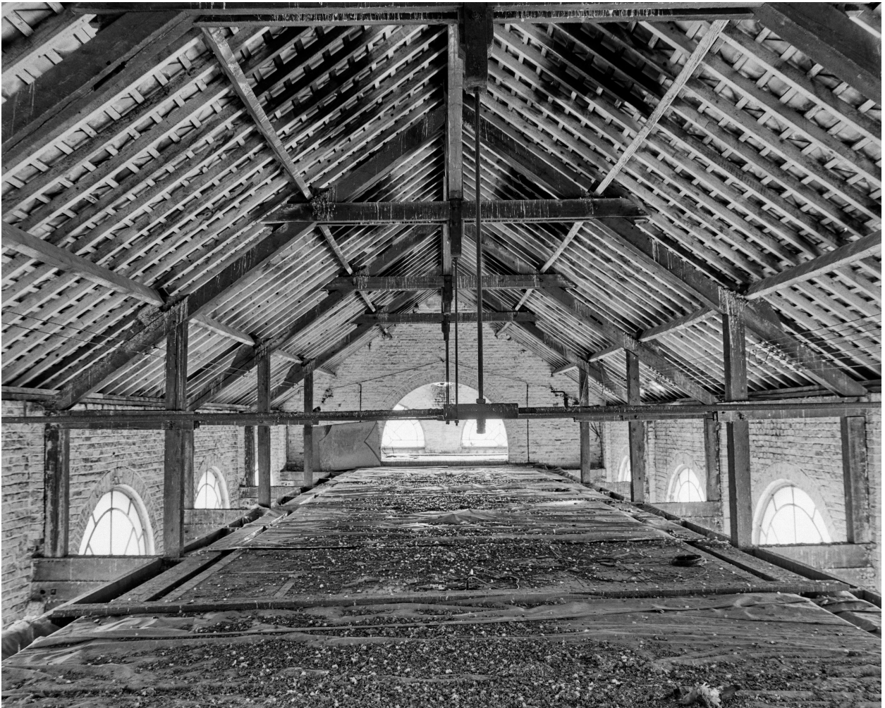
Vue générale des combles.
