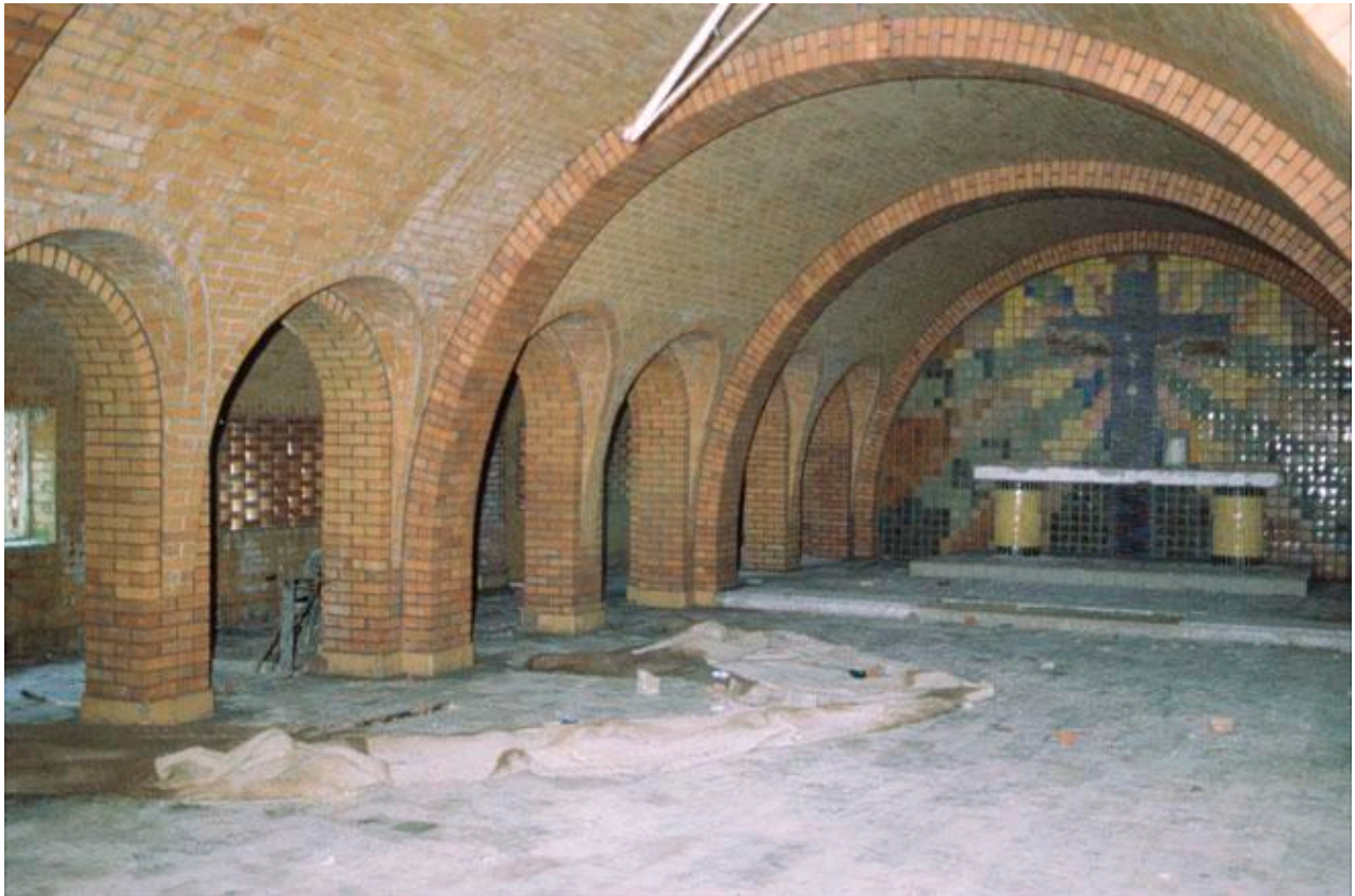
Vue générale de la crypte, vers le chœur.
