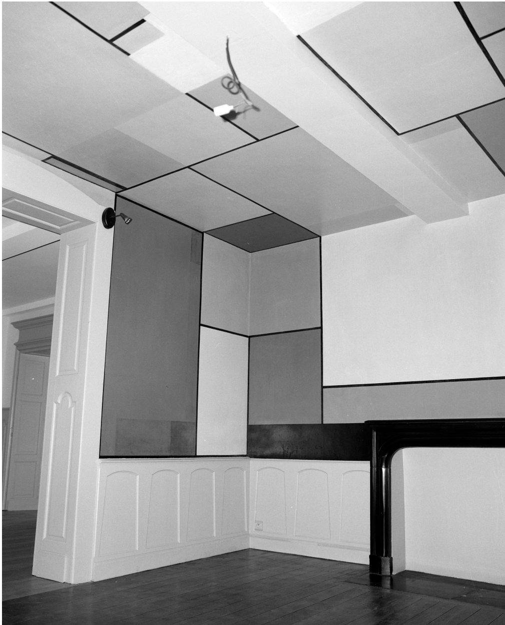
Pièce décorée par Félix Del Marle (1889-1952) à l'issue de la campagne de restauration (mars 2002) : vue en contre-plongée des murs 3B 2B et le plafond.
