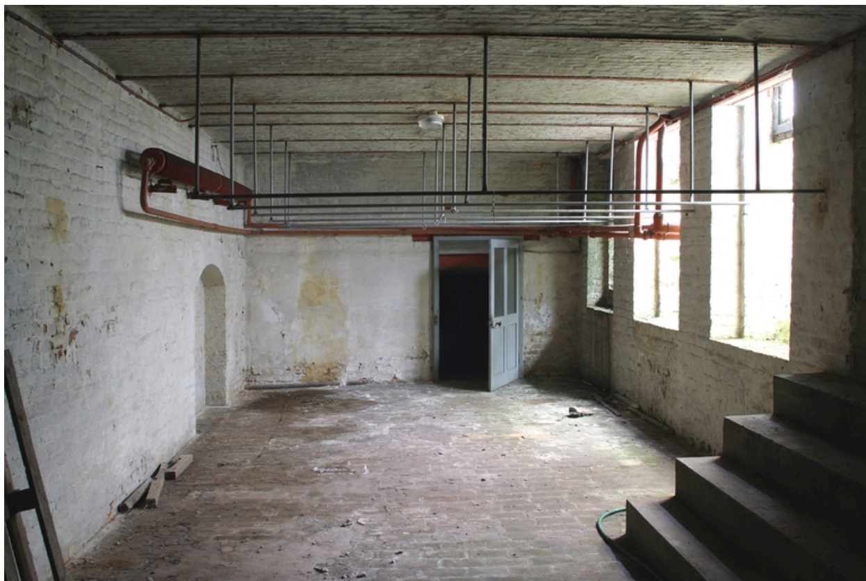
Sous-sol des ateliers de 1870-1880 : ancien atelier de mécanique en 1914.
